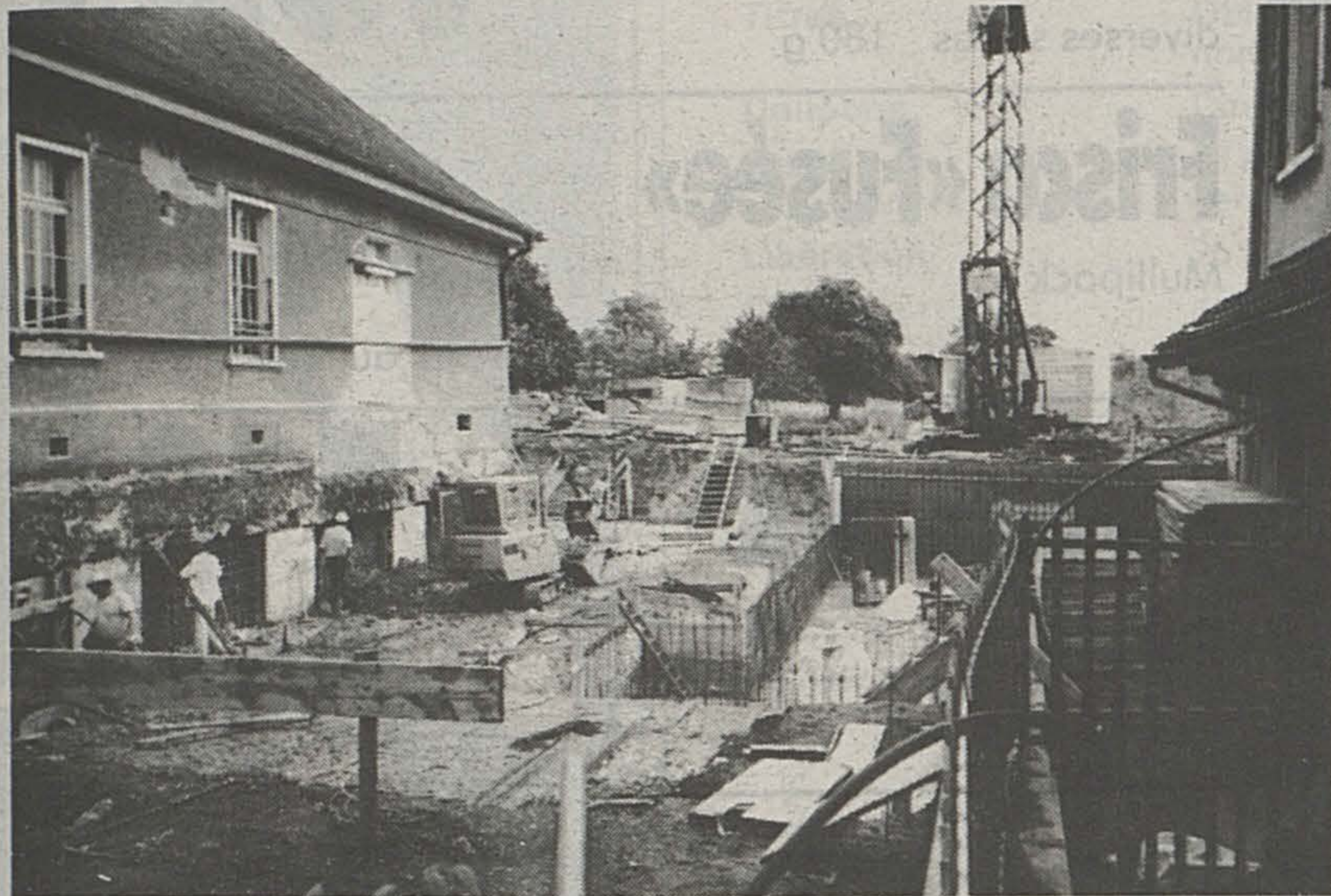
Les travaux en cours. — (photo ol/m. ryser)
